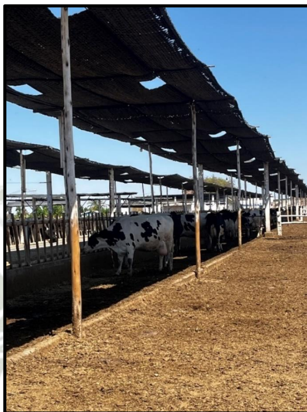
Foto N° 04 Corral de Post Parto
