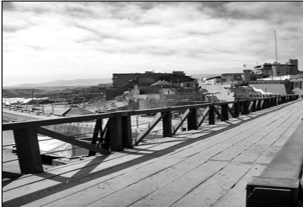
VISTA DESDE ARRIBA DEL PUENTE FIERRO
