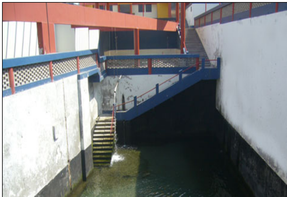
VISTA DE LA ENTRADA DE LOS BAÑOS DE LA AGUADITA
