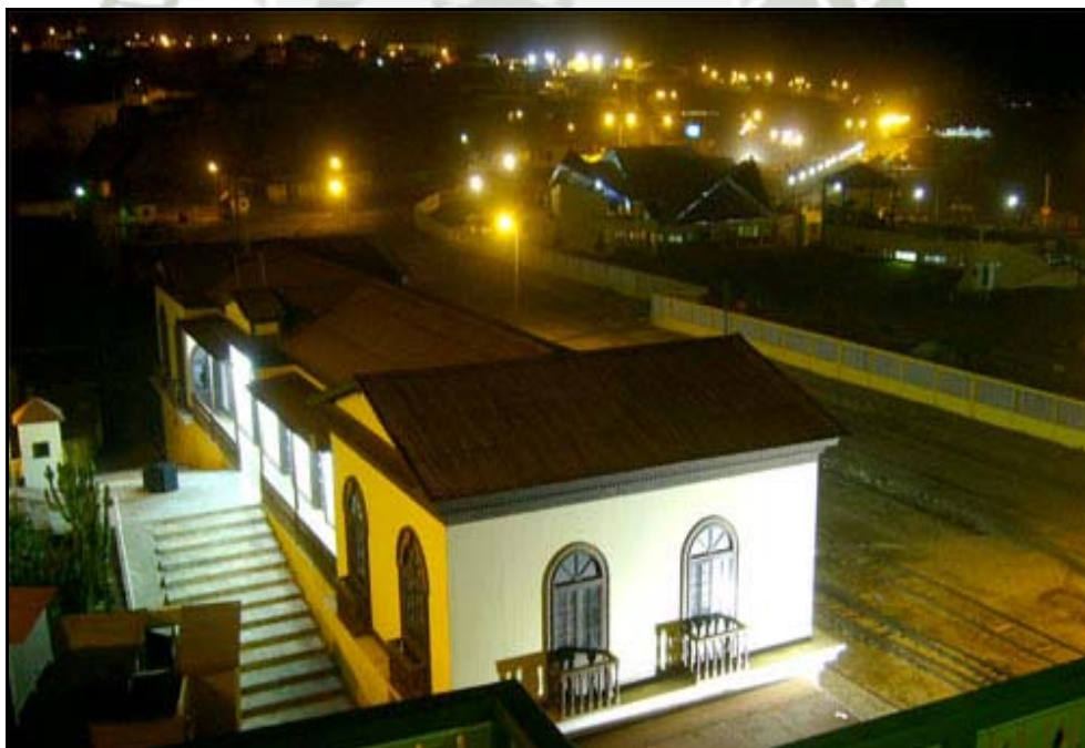
VISTA PANORÁMICA DE LA ESTACIÓN
