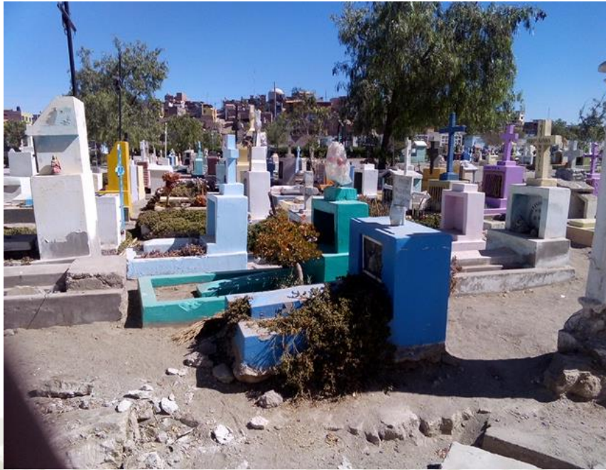
Foto 3. Sector Tumbas, se observa que están sobre terreno sin vegetación.
