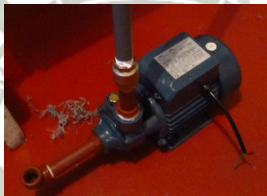
Fig. 3.79 Armado de la tubería de succión.
