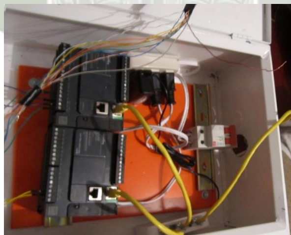
Fig. 3.105 Cableado interno con los elementos ya fijos
