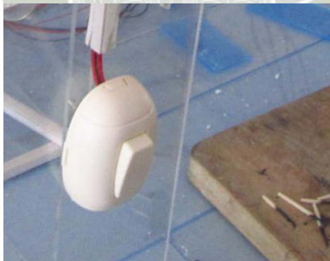
Fig. 3.22 Interruptor para el circuito de control total de iluminación
