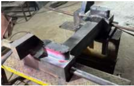
FOTO 19: Equipos de inspección de soldaduras.
