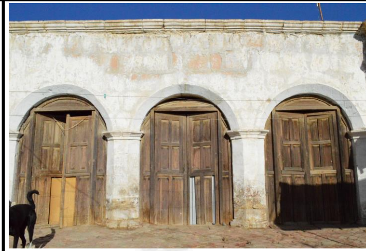
VISTA EXTERIOR (ARQUERÍA)
