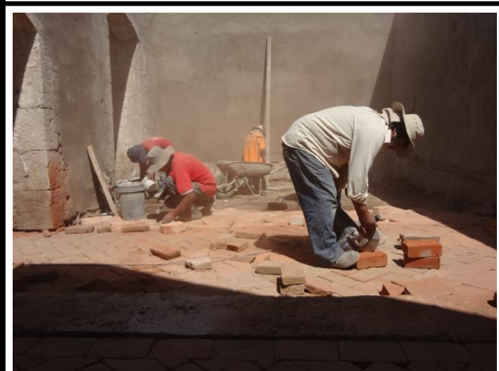
PROCESO DE RESTAURACIÓN
