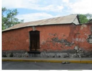
Casa en Paucarpata utiliza sillar en vanos y piedra pircada y bolonería
