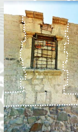
Encuentro de muro de adobe con esquina reforzada con sillar, nótese la textura que resulta del estuque uniforme de ambos materiales, y cómo el adobe pierde el color más rápidamente.
