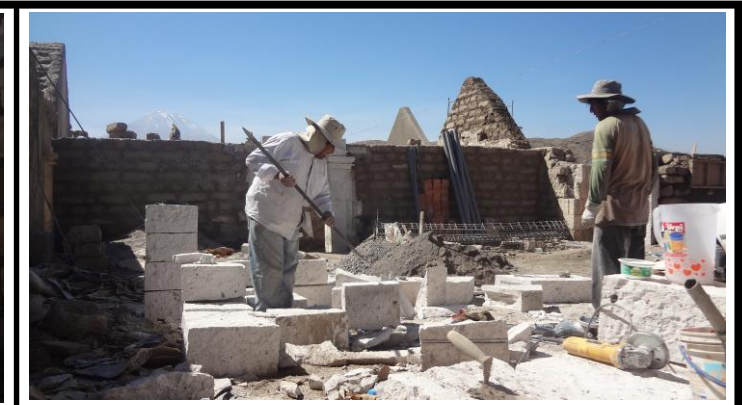
PROCESO DE RESTAURACIÓN
