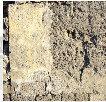
Encuentro de muro de adobe con esquina reforzada con sillar, nótese la textura que resulta del estuque uniforme de ambos materiales, y cómo el adobe pierde el color más rápidamente.
