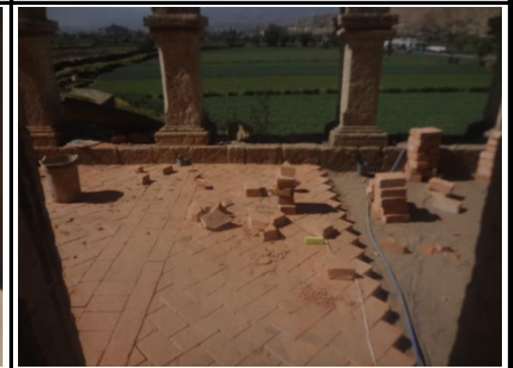
PROCESO DE RESTAURACIÓN
