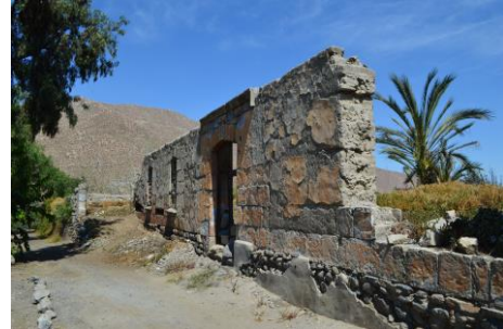
Ilustración 32 Casa Paz Barriga en ruinas en Tiabaya, legible como fuente de información (Fuente: Fotografía Propia)
