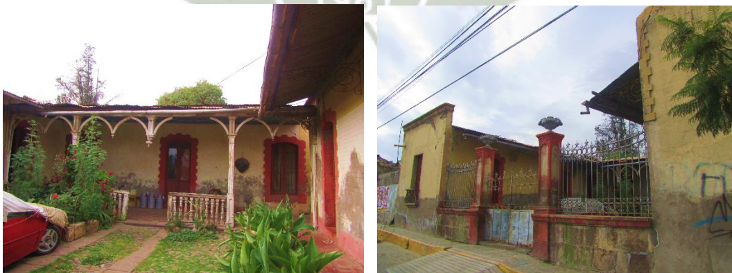
Ilustración 81 Casa de la Familia De Romaña en Sabandía, interior y exterior (Fuente: Autoría Propia)
