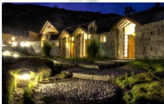
Ilustración 52 Materialidad de la Arquitectura en el Colca Lodge (Fuente: colca-lodge.com)
