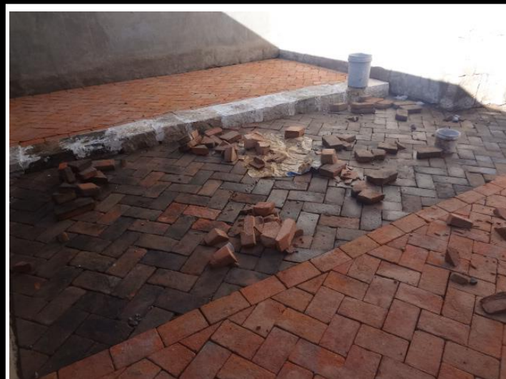
PROCESO DE RESTAURACIÓN
