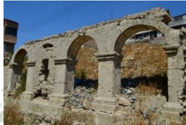
Ruinas de casa en sector de Pasos del Señor, presenta arquería de sillar blanco.
