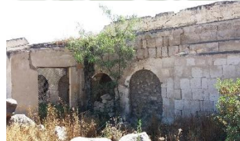
Corredor en la Ruinosa Quinta Vivanco al costado de la UCSP
