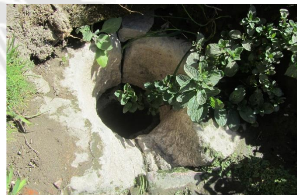
DRENAJE con piezas de sillar ubicado en una de esquina de los cultivos, nótese la peculiar forma que tienen dichas piezas.
