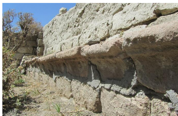
SILLAR TORNEADO a modo de piezas ubicado en una banca pegada al muro perimetral.
