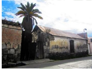
Casa en Sabandía utiliza sillar en vanos y piedra pircada en muros.
