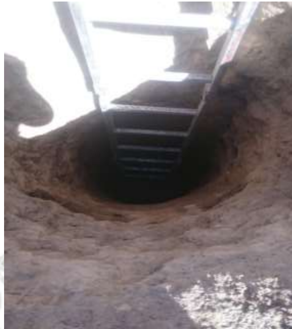
FIGURA N° 2 Calicata Realizada (Fuente Propia)
