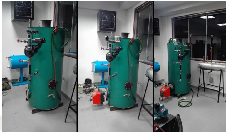
Figura 27. Instalación de sistema de automatización de caldera
