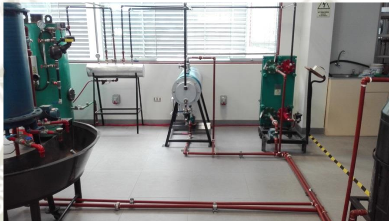
Figura 29. Instalación de sistema de vapor
