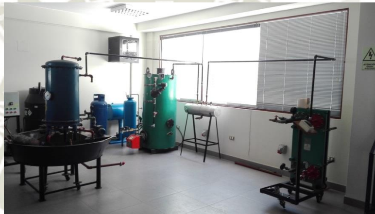
Figura 28. Instalación de línea de vapor
