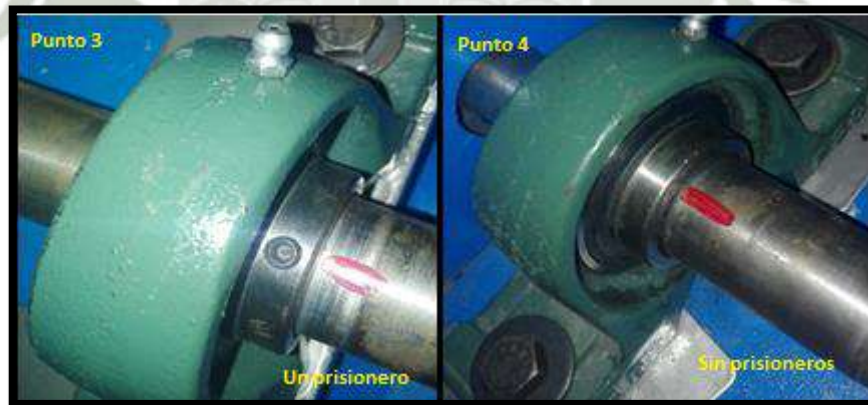
Figura 6: Marca de referencia para el punto 3 y 4. Fuente: Propia.
