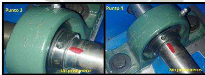
Figura 6: Marca de referencia para el punto 3 y 4. Fuente: Propia.
