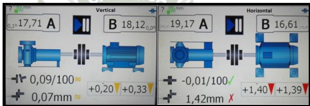
Figura 3.27: Desalineación paralela horizontal. Fuente: Propia, Alineador de ejes TKSA 80.
