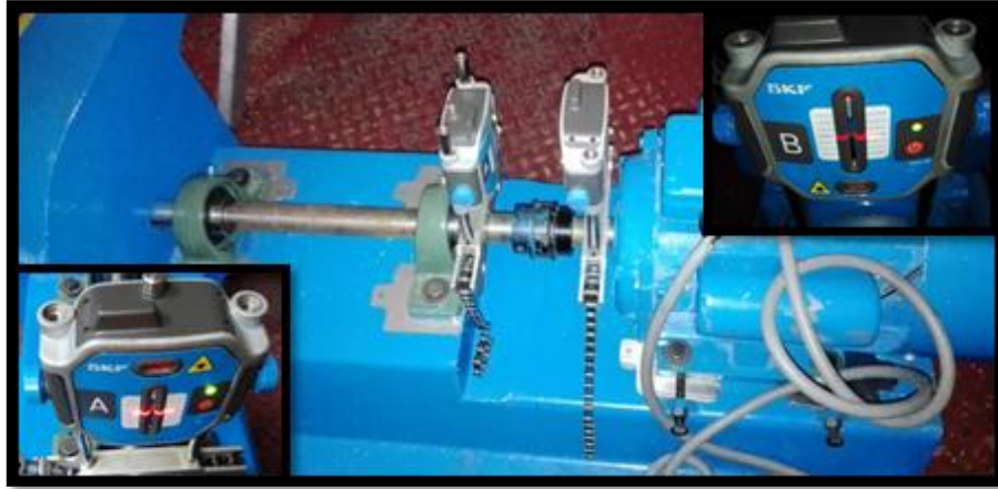
Figura 3.23: Montaje de alineador láser en módulo. Fuente: Propia.
