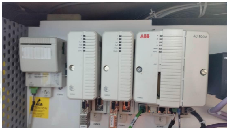
Fig. 6.22 Procesador AC800
