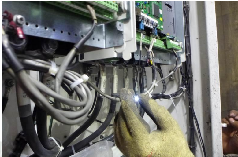
Fig. 6.20 Verificación de la continuidad de la fibra óptica mediante haz de luz
