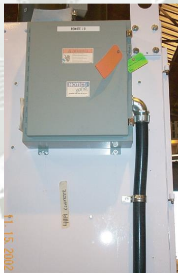
Fig. 3.18 Módulo de I/O Remotas
