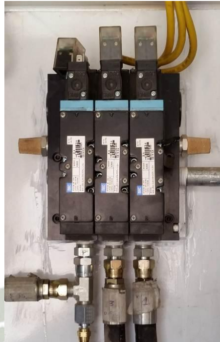
Fig. 6.15 Solenoides de los frenos
