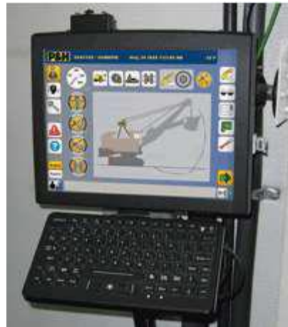
Fig. 6.39 Sala de máquinas – Touch panel
