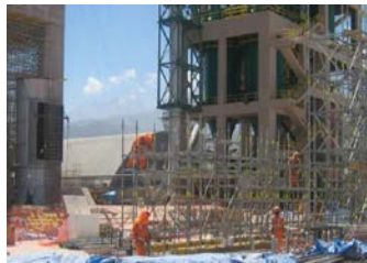
CUADRILLA DE TRABAJO: Trabajo en parejas; 01 Coloca Elementos y otra Acarrea y/o Habilita elementos necesarios.
