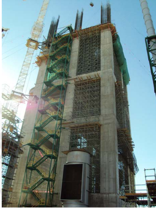
Foto 4.12: Vaciado de Tercer Nivel Nv.+2635.93
