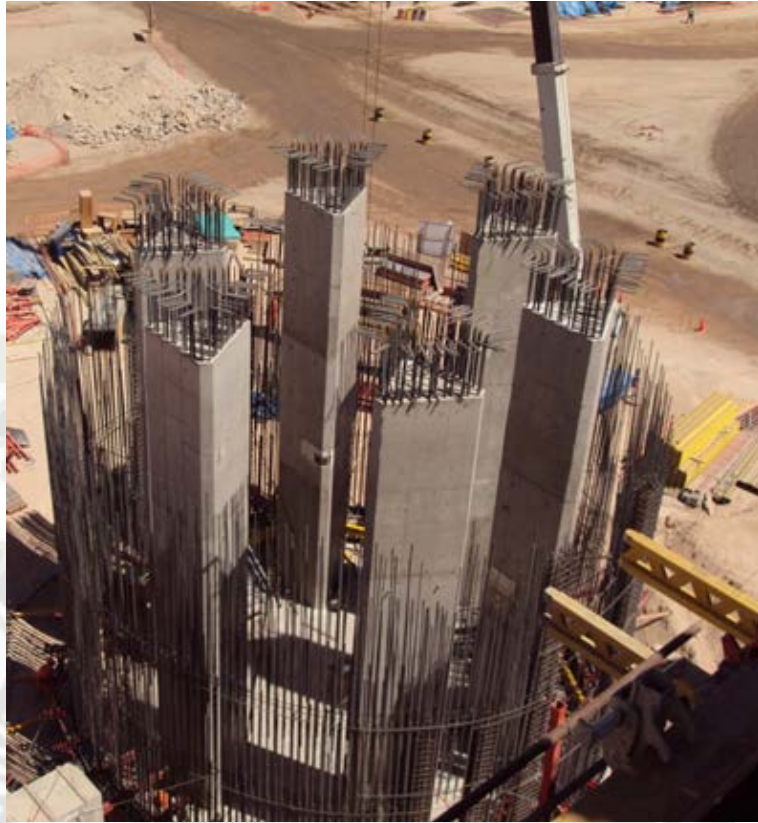
Foto 4.20: Columnas Centrales Triangulares
