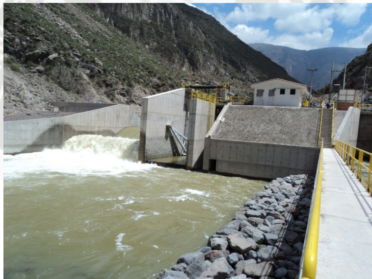
Foto 5.2: Obras de Captación – Vista Aguas Abajo
