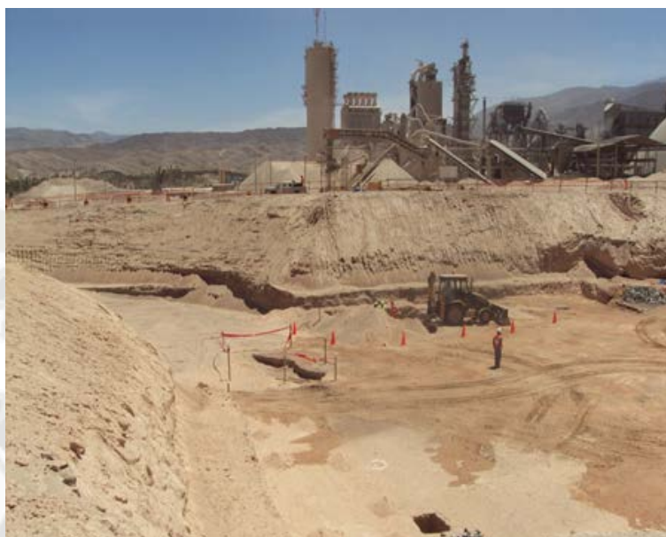
Foto 4.6: Excavación de Cimentación de Intercambiador de Calor
