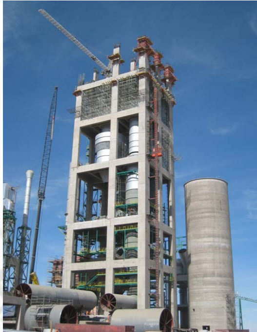
Foto 4.16: Ejecución de Columnas Sexto Nivel Nv.+2686.13
