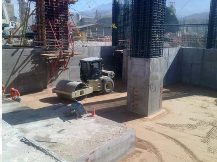
Foto 4.8: Relleno de Cimentación
