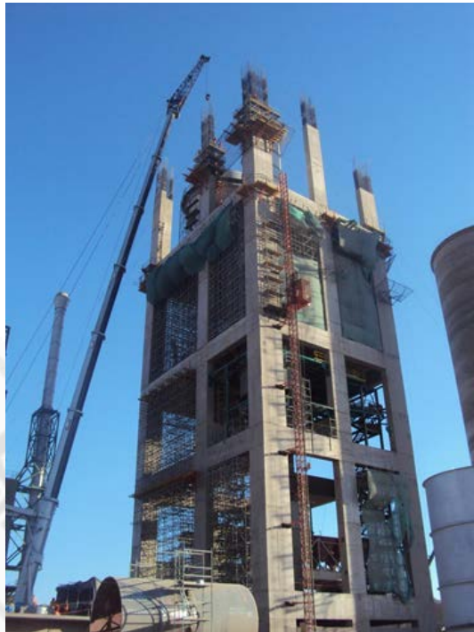
Foto 4.14: Vaciado de Columnas Cuarto Nivel Nv+2654.53
