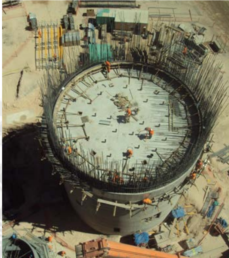
Foto 4.22: Vaciado de Losa Intermedia
