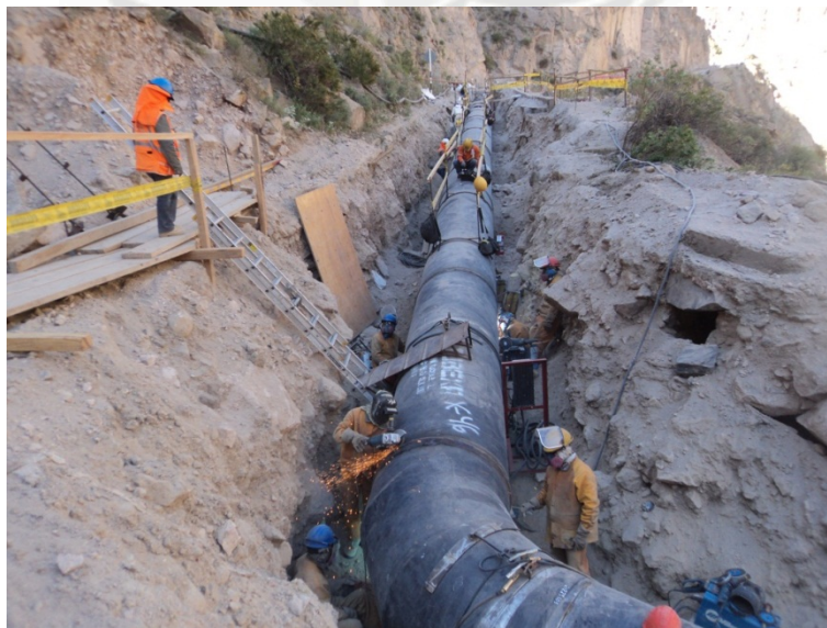
Foto 5.6: Tubería de Acero al Carbono – Tramo 4
