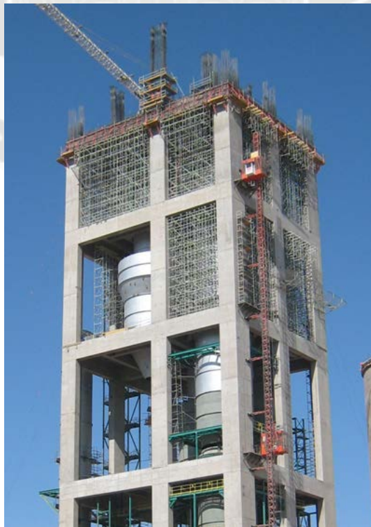
Foto 4.15: Vaciado de Losa Quinto Nivel Nv.+2670.53
