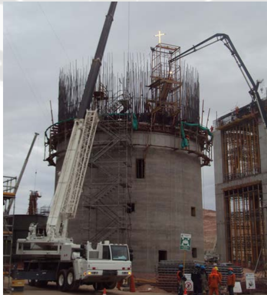
Foto 4.23: Vaciado de Fuste Superior
