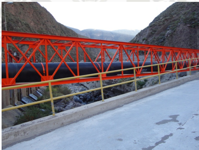
Foto 5.3: Puente Aéreo N°1
