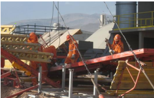
HABILITACIÓN DE PANELES (T. Contributorio)
