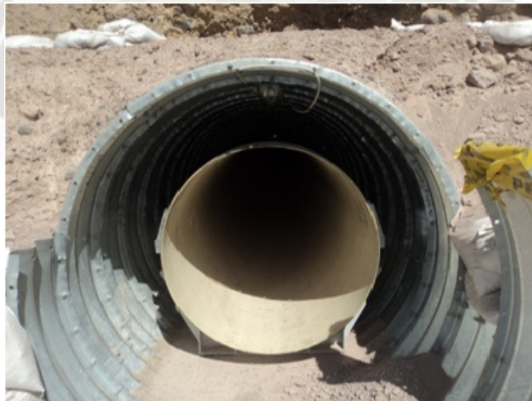
Foto 5.8: Instalación de Tubería en Túnel Liner
