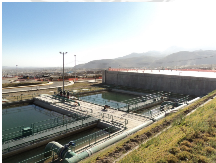
Foto 5.11: Depósitos de Agua Tratada y Pozas de Sedimentación
