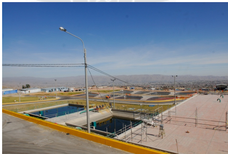
Foto 5.11: Pozas de Sedimentación y Pozas de Fangos
