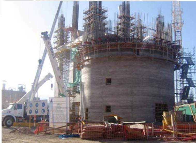
Foto 4.21: Vaciado de Fuste Inferior
