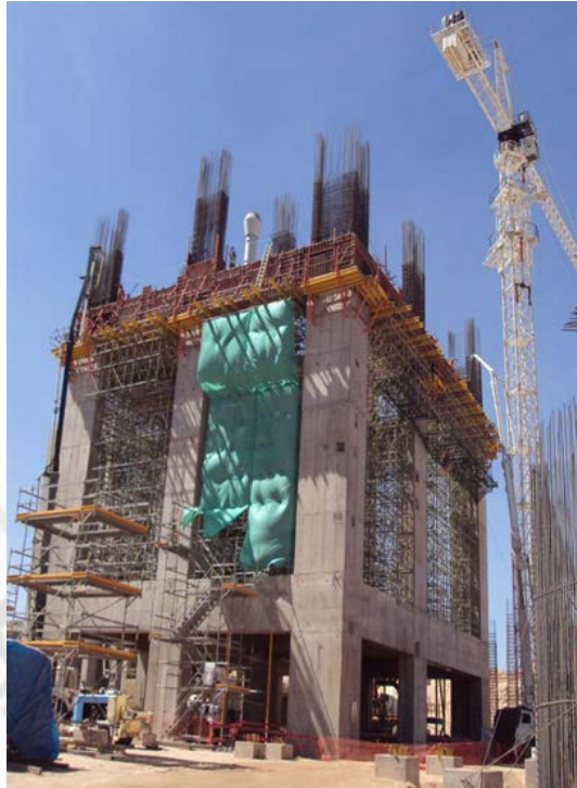
Foto 4.10: Vaciado de Viga Collar Nv.+2601.24
