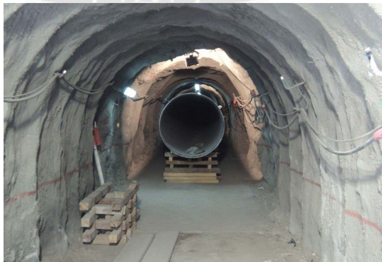
Foto 5.7: Túnel N°2 – Instalación de Tubería.
