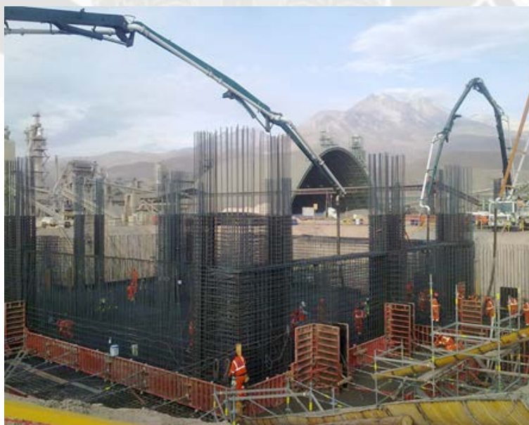
Foto 4.7: Vaciado de Cimentación
