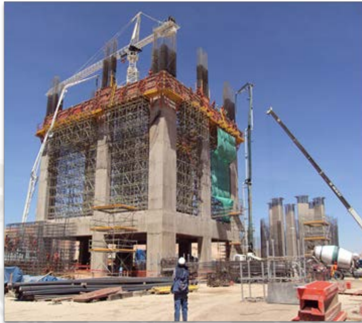
Foto 4.4: Vaciado de Vigas con Bombas Móviles
