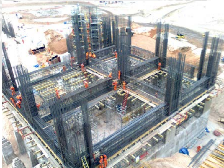
Foto 4.9: Losa del Primer Nivel Nv.+2584.33
