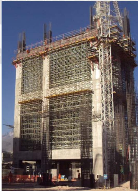
Foto 4.11: Vaciado de Losa Segundo Nivel Nv.+2615.13
