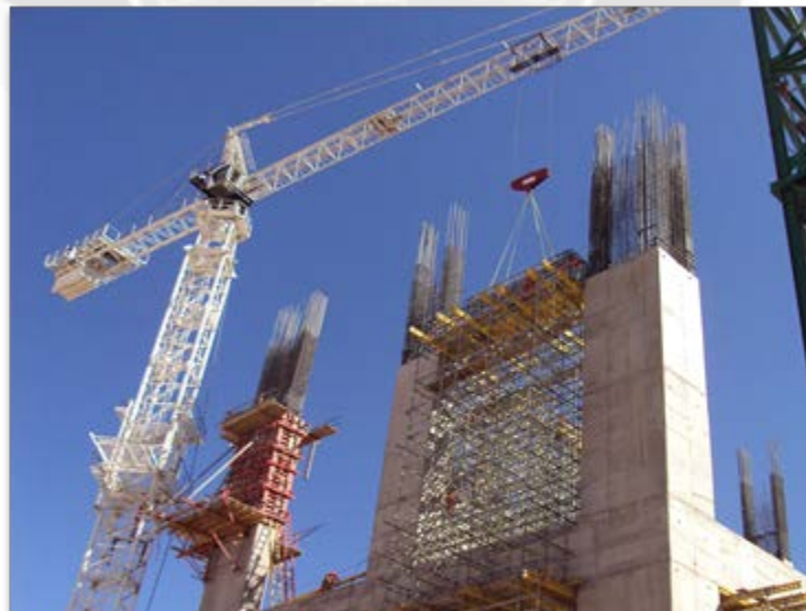
Foto 4.5: Uso de Grúa Torre para Izaje de Acero
