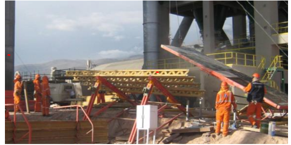
ESPERAS POR MANIOBRA DE GRÚA TORRE (T. No Contributorio)
