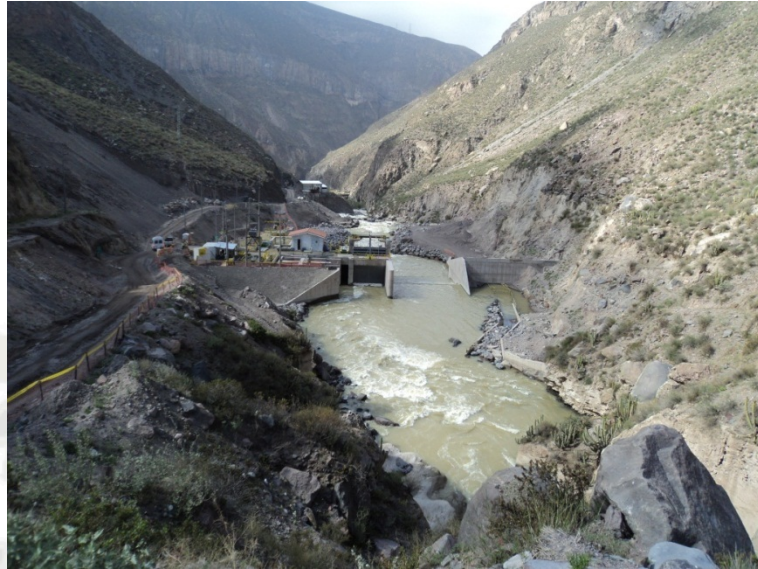
Foto 5.1: Obras de Captación – Vista Aguas Arriba
