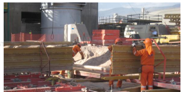
HABILITACIÓN DE PANELES Y SUJECIÓN DE ELEMENTOS
