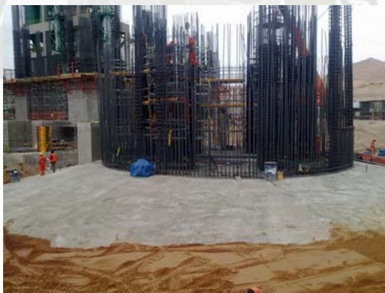
Foto 4.19: Cimentación de Silo de Homogenización
