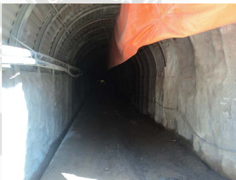
Foto 5.4: Salida de Túnel N°1
