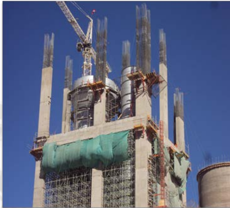
Foto 4.2: Interacción Montaje Mecánico en Intercambiador de Calor
