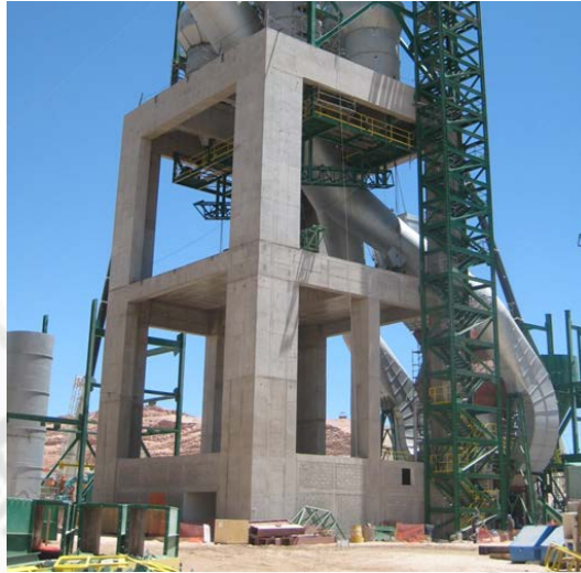
Foto 4.26: Edificio de Ciclonas
