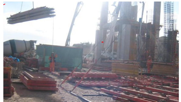
ESPERAS POR IZAJE DE MATERIALES GRÚA TORRE (T. No Contributorio)
