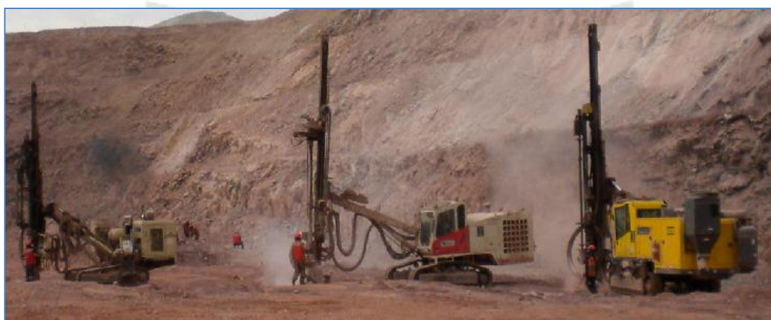
Fotografía N° 4: Equipos de Perforación: ECM 590, R30C terex, ECM 720
