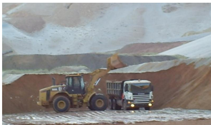
Fotografía N° 6: Cargador frontal 950H y volquete Scania 15 m 3
