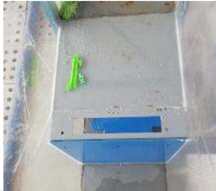
Fotografía N° 28.- Instalación de la mesa en volado del vertedero
