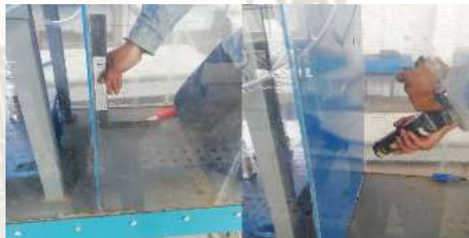
Fotografía N° 29.- Instalación de la plancha de desnivel
