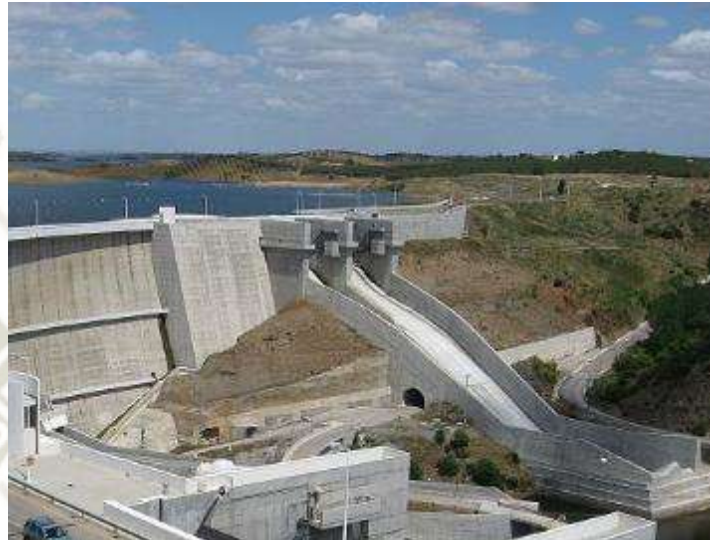
Figura N° 11.- Presa de Alqueva, Portugal
