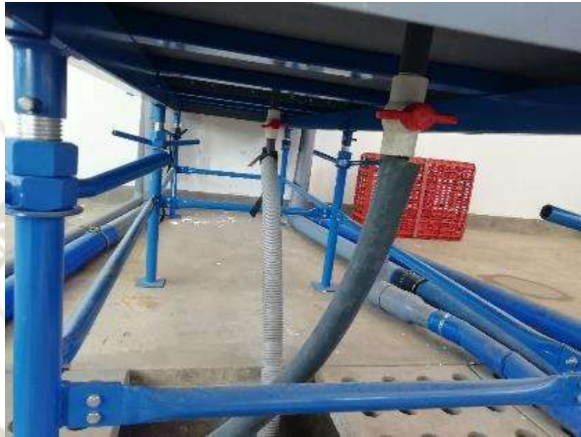
Fotografía N° 3.- Puntos de desagüe en el pozo de disipación
