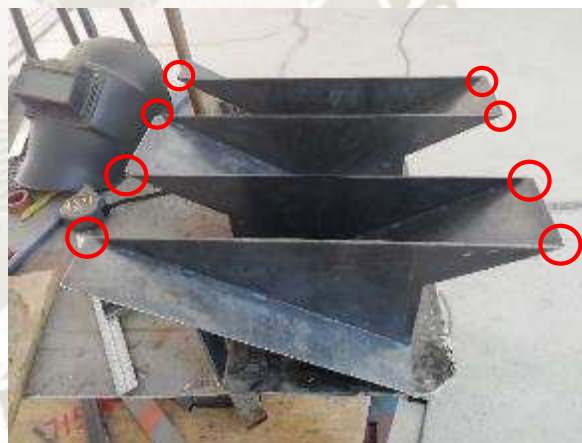
Fotografía N° 19.- Nivelado de la base y detalle de cresta
