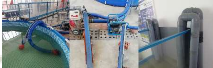
Fotografía N° 9.- Tuberías de succión, impulsión y llegada
