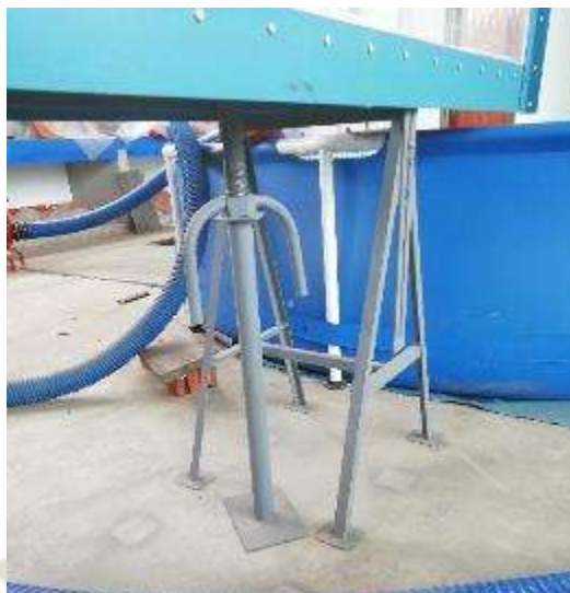
Fotografía N° 7.- Soporte típico y extra del canal aguas abajo
