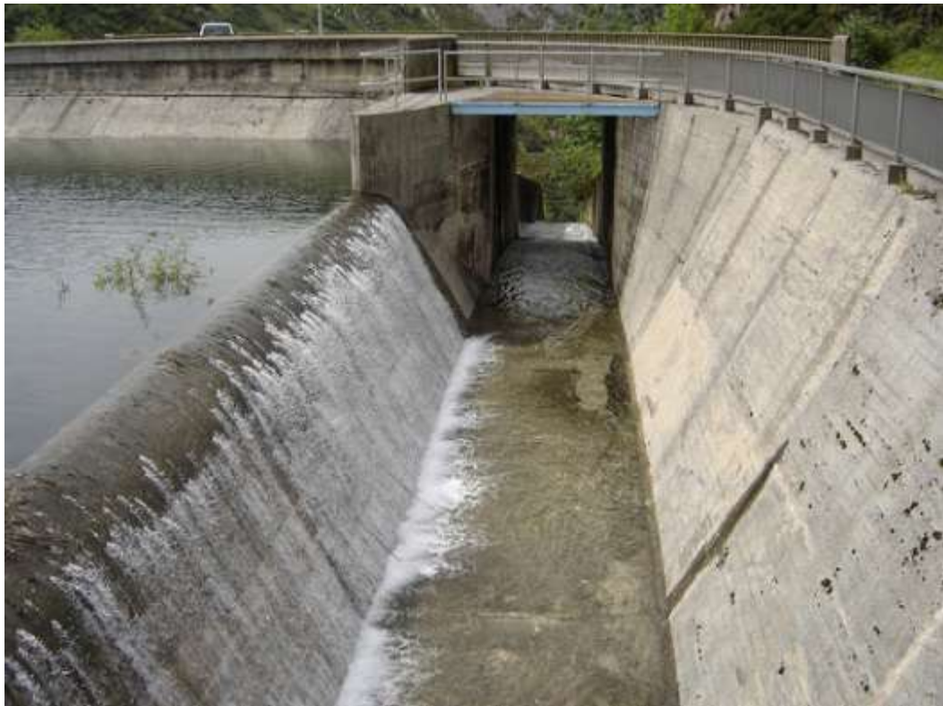
Figura N° 9.- Vertedero de la presa de los Alfилorios
