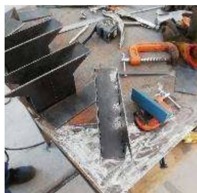
Fotografía N° 17.- Soldadura de teclas independientes
