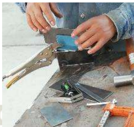
Fotografía N° 18.- Soldadura del vertedero
