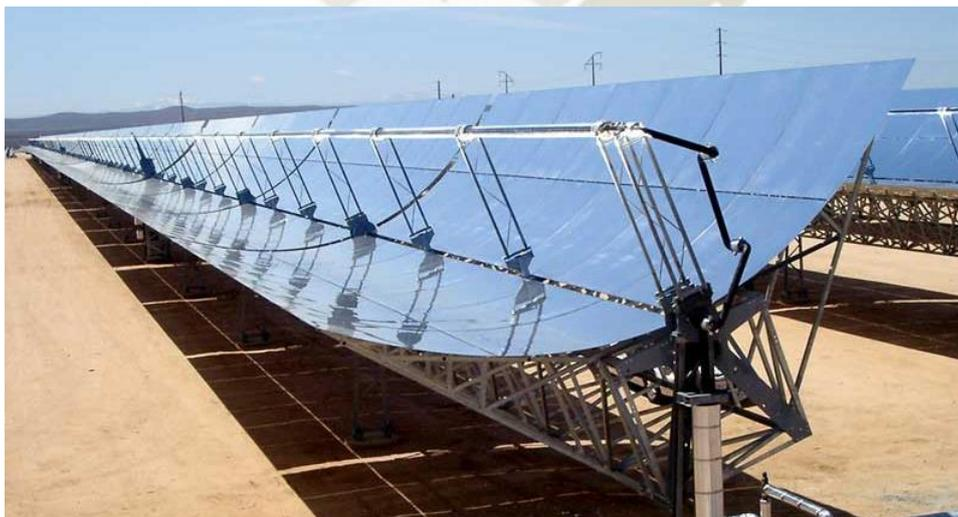
**Figura 3. 8 - Colector Cilindro Parabólico**
