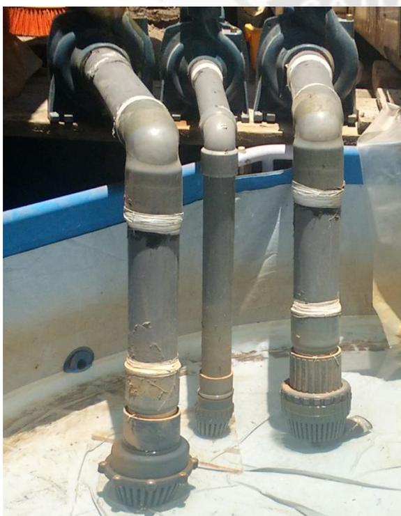
Fotografía 6.6 Tuberías de Impulsión
