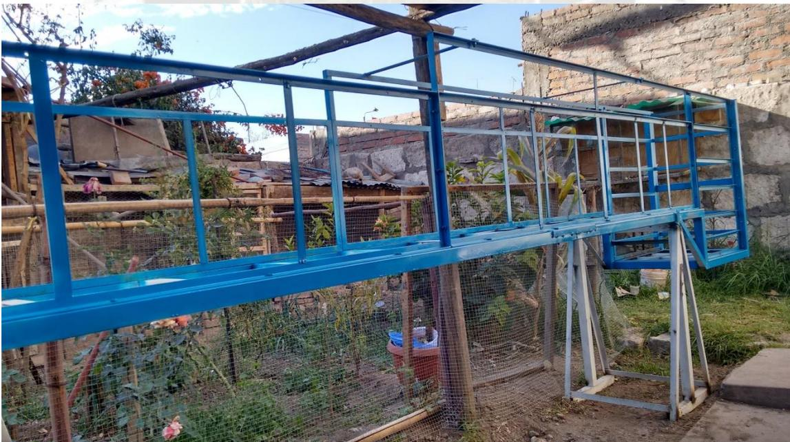
**Fotografía 6.2** Estructura metálica del canal instalada en el lugar del modelamiento
