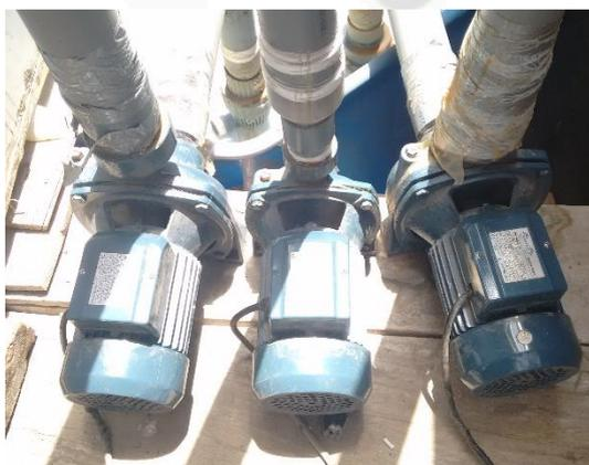
Fotografía 6.8 Bombas centrífugas, se colocó en la unión cinta industrial para reducir filtraciones
