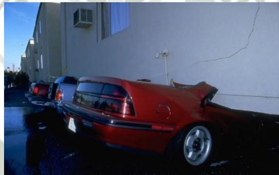
*Fig. 1.1 - Edificio colapsado por efecto de piso blando, Northridge 1994.
