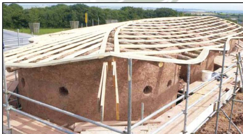
Figura 2-9: Muros de cob y estructura de cubierta en el Pabellón de Servicios del Edén Project, Cornwall, Reino Unido.
