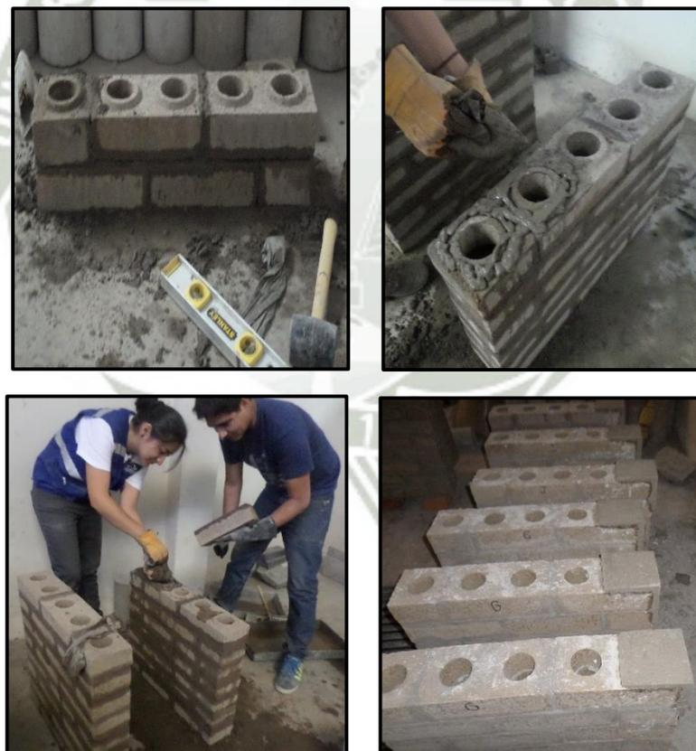
Figura 6-17: Procedimiento de construcción de muretes
