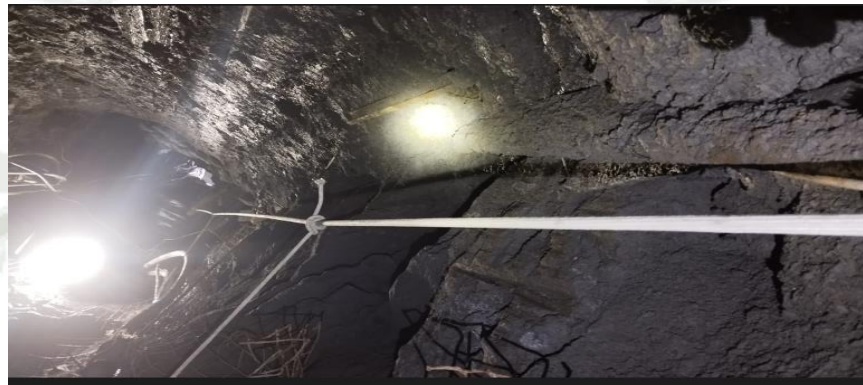
Acceso a Chimenea
