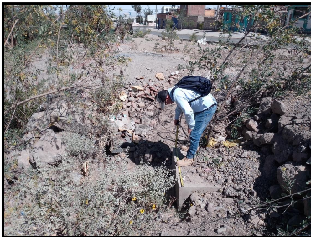
Se encontró alcantarillas de drenaje pluvial.
