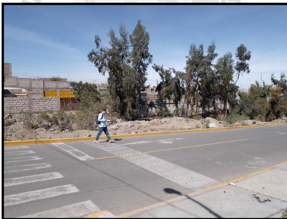
Las alcantarillas de drenaje pluvial direccionan el agua de lluvia a la quebrada.
