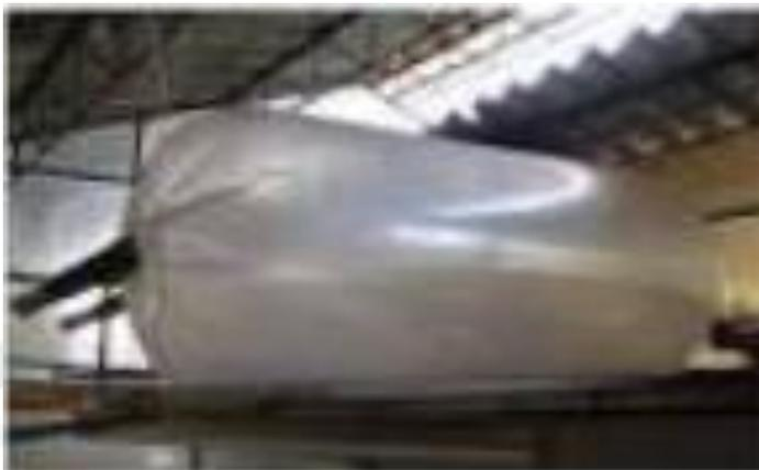
**Figura 62 Reservorio de biogás**
