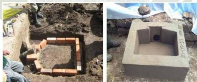
**Figura 60 Poza de entrada o alimentación del biodigestor**
