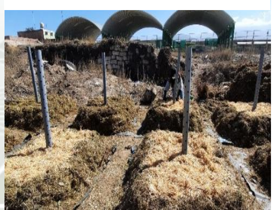
Instalación de las 12 pilas
