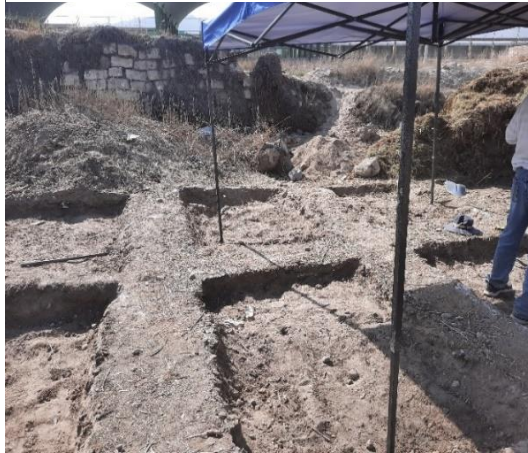
Elaboración de desnivel para instalación de pilas
