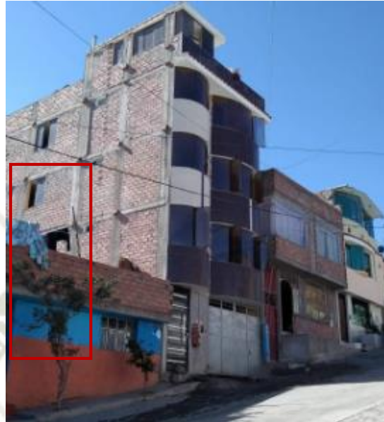
Figura 8: Ejemplo 4 de vivienda con errores constructivos.
