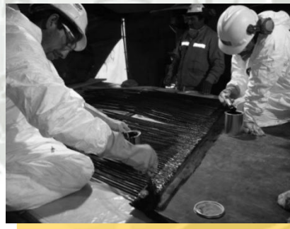
Imagen 3.2. Personal de la Empresa Trabajando
