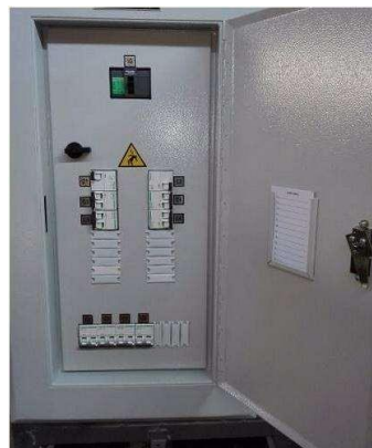
Figura N°. 17. Termomagnético de 3x250Amp
