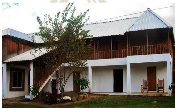
Sala de reuniones y eventos, segundo nivel del edificio principal
