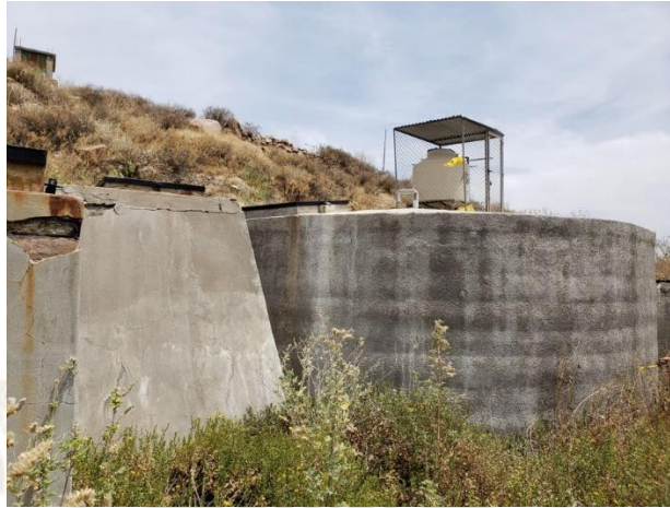
Figura 44: Sistema de cloración del agua
